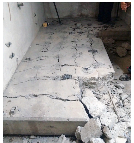
Betonfundering binnenshuis gesloopt
