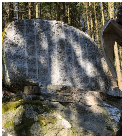
Zwerfkei in het bos geruisloos in schijven gescheiden
