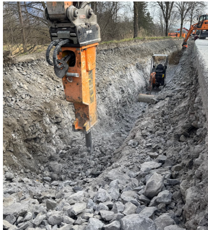
Sleufuitgraving in rots – materiaal voorgesplitst
