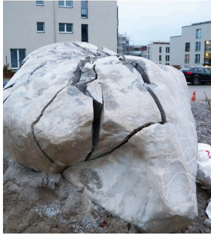
Zwerfkei in woonwijk trillingsvrij gespleten
