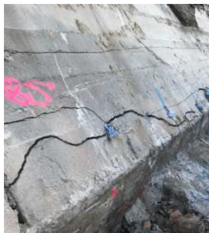
Zid de beton fisurat controlat de-a lungul șirului de găuri
