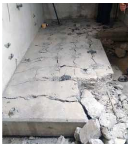
Rušenje betonskog temelja u zatvorenom prostoru
