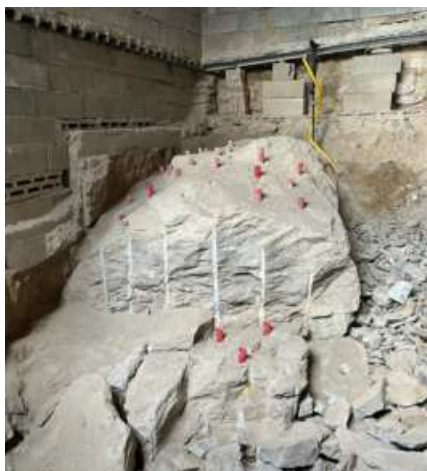
Rušenje stijene u podrumskom prostoru umjesto štemanja
