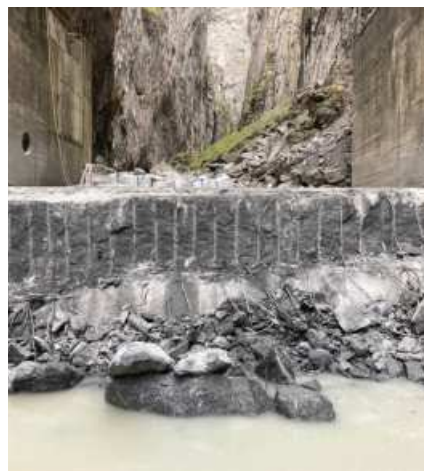
Rušenje betonske brane u klanu
