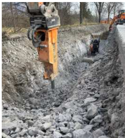
Iskop rova u stijeni – materijal prethodno razrahljen
