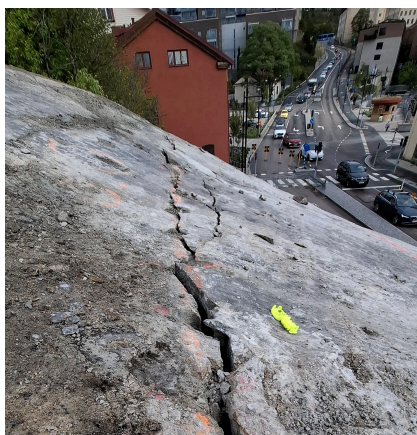
Retirada de roca sobre una carretera muy transitada
