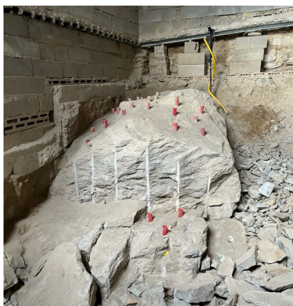
Rotura de roca en sótano en lugar de cincelado
