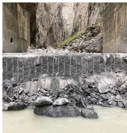
Desmontaje de una barrera de hormigón en un desfiladero
