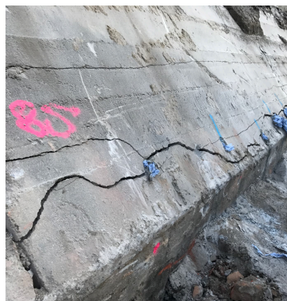
Muro de hormigón fisurado de forma controlada a lo largo de la fila de barrenos
