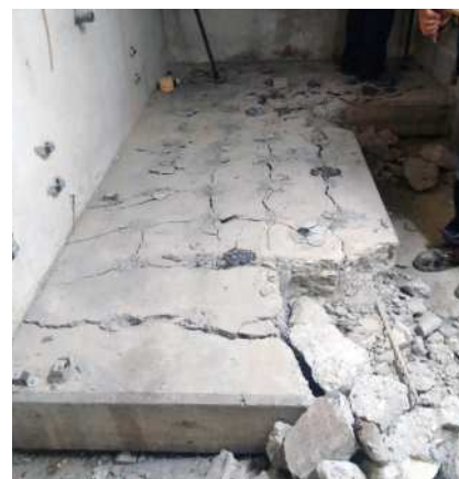
Fondation en béton démolie à l'intérieur
