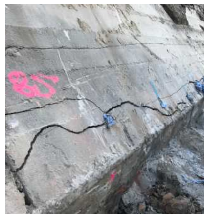
Mur en béton fissuré de manière contrôlée le long de la rangée de trous
