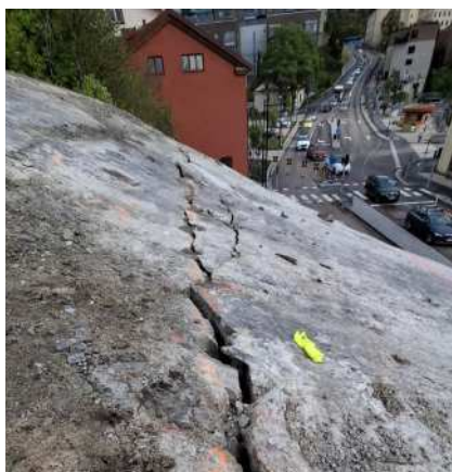
Purge de rocher au-dessus d'une route très fréquentée
