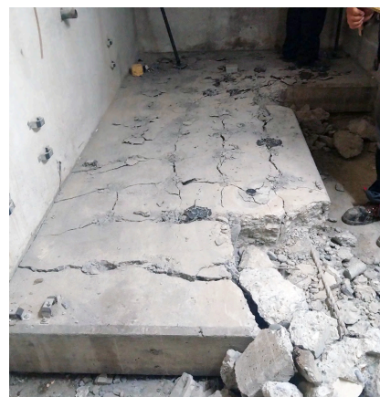
Fondation en béton démolie à l'intérieur
