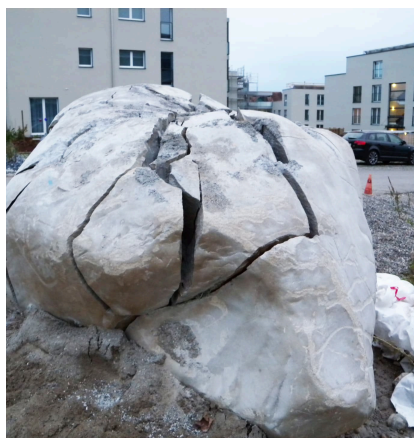
Bloc erratique en zone résidentielle fendu sans vibrations
