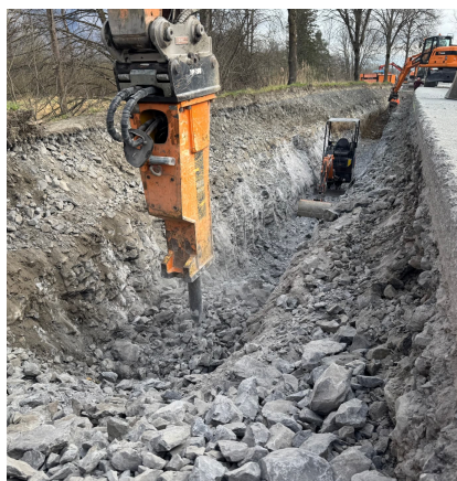
Creusement de tranchée dans la roche – matériau ameubli au préalable
