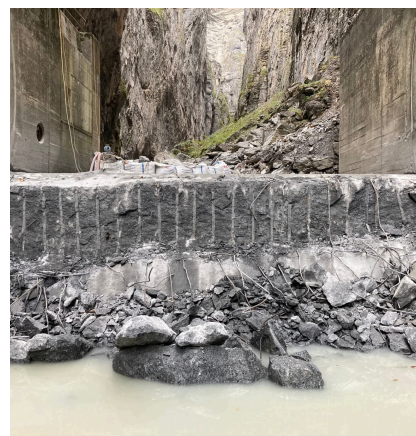
Démantèlement d'un barrage en béton dans une gorge
