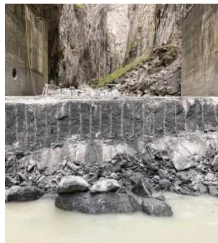
Nedrivning af en betonspærring i en kløft
