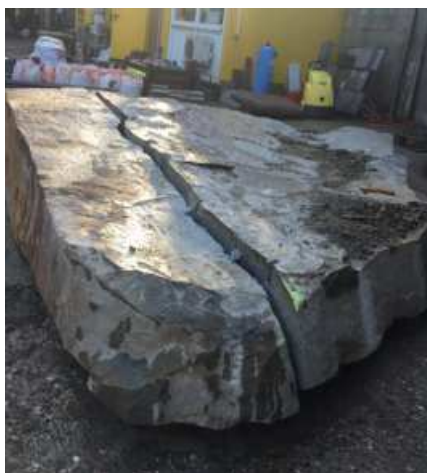
Klippeblok i terrænet kløvet kontrolleret
