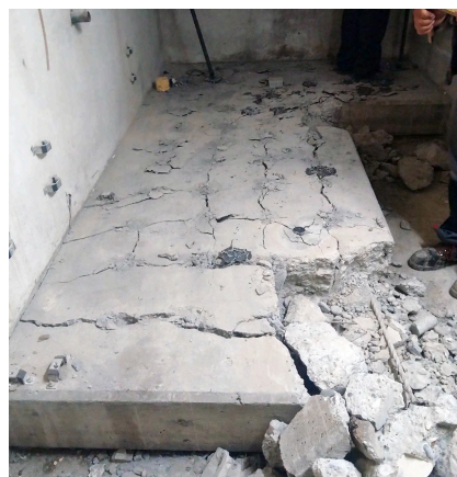
Fondazione in calcestruzzo demolita in interni
