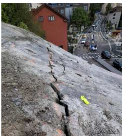
Bergschaktning ovanför en trafikerad väg
