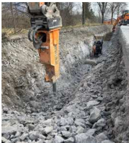
Grøftegraving i fjell – materiale løsnet på forhånd
