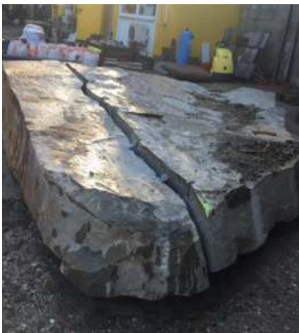
Fjellblokk kontrollert splittet i terrenget
