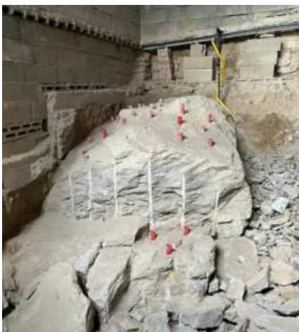
Fjellrivning i kjellerområde i stedet for meisling
