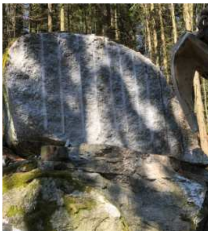
Flyttblokk i skogen delt støyfritt i skiver
