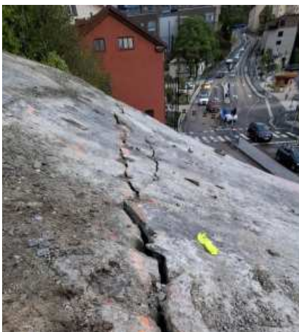
Fjellfjerning over en trafikkert vei
