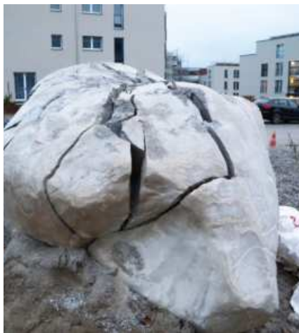
Flyttblokk splittet vibrasjonsfritt i boligområde
