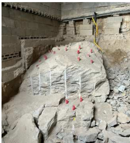
Рушење стене у подруму уместо штемовања
