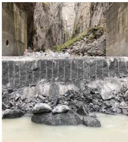
Уклањање бетонске преграде у клисури
