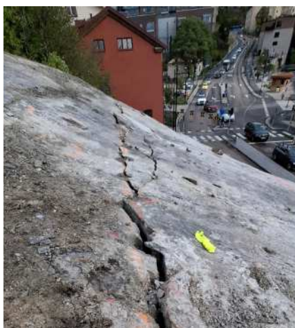
Скидање стене изнад прометног пута
