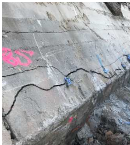
Бетонски зид контролисано испуцао дуж реда рупа
