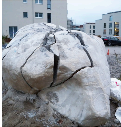
Findling im Wohngebiet erschütterungsfrei gespalten
