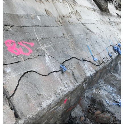
Betonmauer entlang der Bohrlochreihe kontrolliert gerissen
