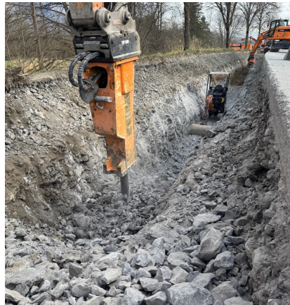
Grabenaushub im Fels – Material vorgelockert
