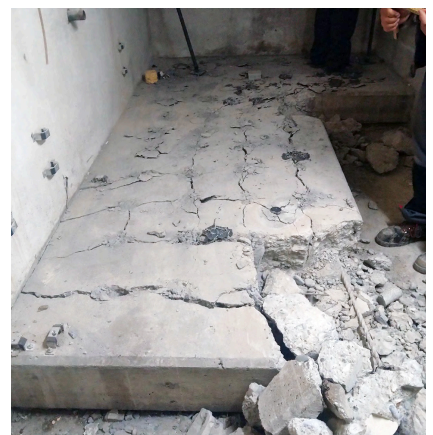
Betonfundament im Innenbereich abgebrochen
