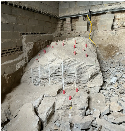
Felsabbruch im Kellerbereich statt Stemmen
