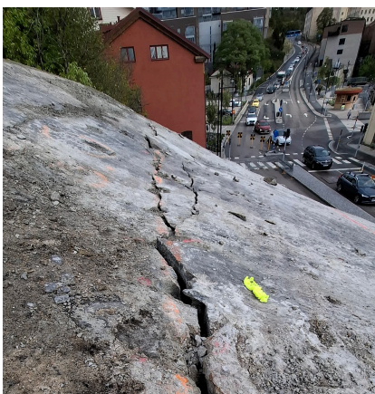
Felsabtrag über einer befahrenen Strasse
