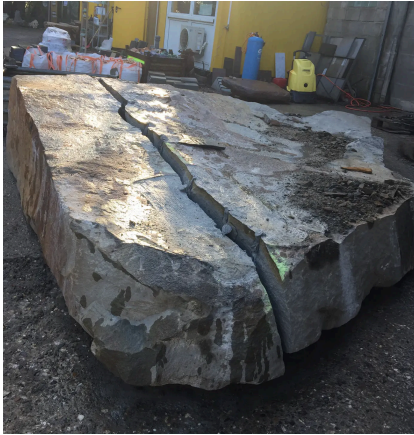
Felsblock im Gelände kontrolliert gespalten
