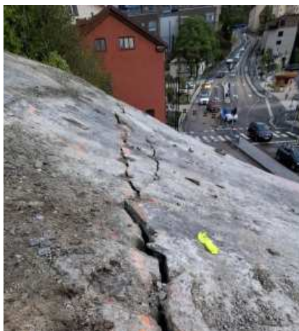
Αφαίρεση βράχου πάνω από δρόμο με κυκλοφορία
