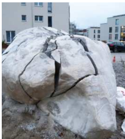
Διαχωρισμός ογκόλιθου σε κατοικημένη περιοχή χωρίς κραδασμούς
