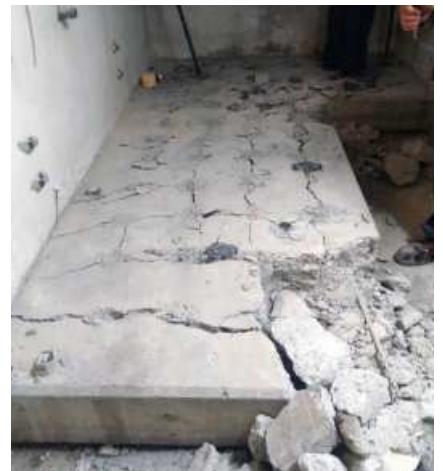
Betoninen perustus purettu sisätiloissa
