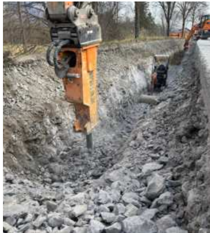
Ojan kaivuu kalliosta – materiaali esihalkaistu
