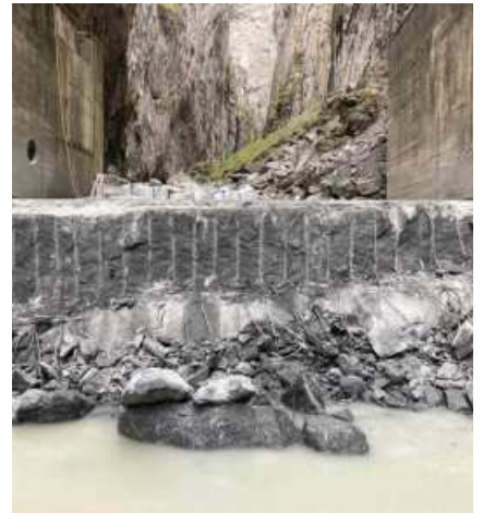
Betonipadon purku rotkossa
