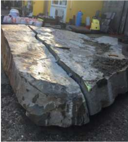
Maastossa oleva kalliolohkare hallitusti halkaistuna
