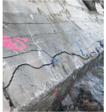
Betonimuuri hallitusti halkaistuna porausrivin kohdalta
