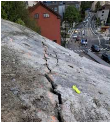
Kallion louhinta liikennöidyn tien yläpuolella
