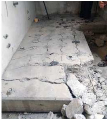
Wyburzenie fundamentu betonowego wewnątrz budynku
