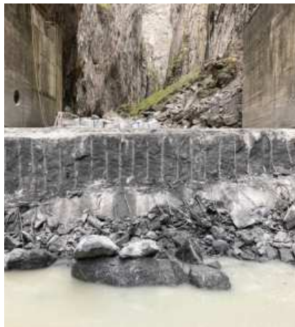
Rozbiórka zapory betonowej w wąwozie
