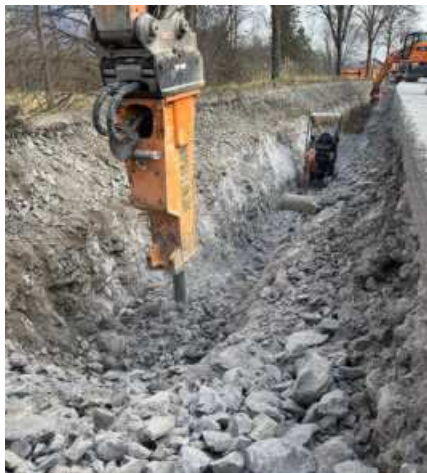
Wykop w skale – wstępne odspojenie materiału
