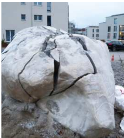
Bezwybuchowe rozłupanie głazu narzutowego w strefie mieszkalnej
