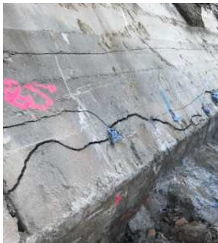
Kontrolowane pękanie ściany betonowej wzdłuż rzędu otworów
