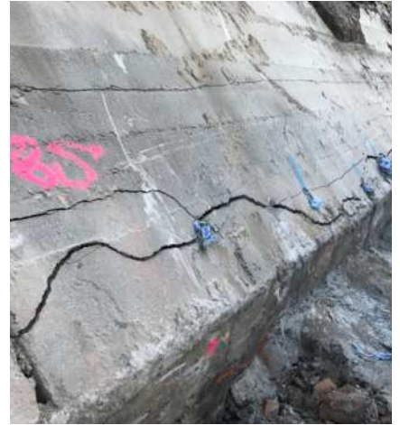
Betonmuur langs de boorgatenrij gecontroleerd gescheurd
