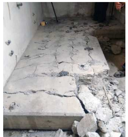
Betonfundering binnenshuis gesloopt
