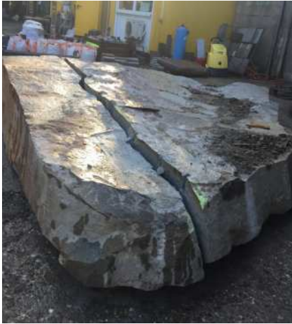
Rotsblok in het terrein gecontroleerd gespleten
