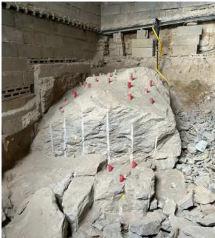
Rotsafbraak in de kelder in plaats van hakken
