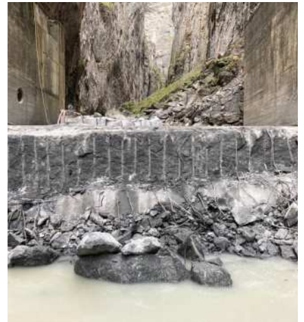
Sloop van een betonnen kering in de kloof
