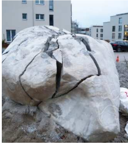
Zwerfkei in woonwijk trillingsvrij gespleten
