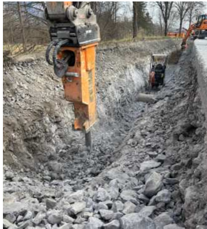
Sleufuitgraving in rots – materiaal voorgesplitst
