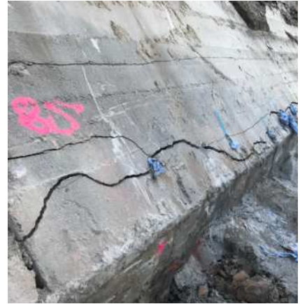
Betonmauer entlang der Bohrlochreihe kontrolliert gerissen
