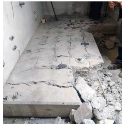
Betonfundament im Innenbereich abgebrochen
