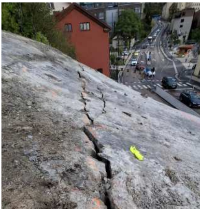
Felsabtrag über einer befahrenen Strasse
