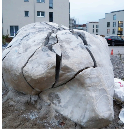
صخرة في منطقة سكنية تم شققها بلا اهتزازات
