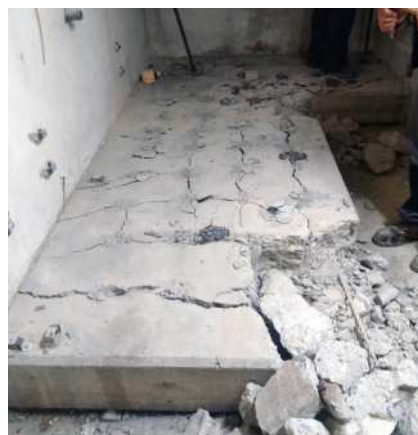
Fondazione in calcestruzzo demolita in interni
