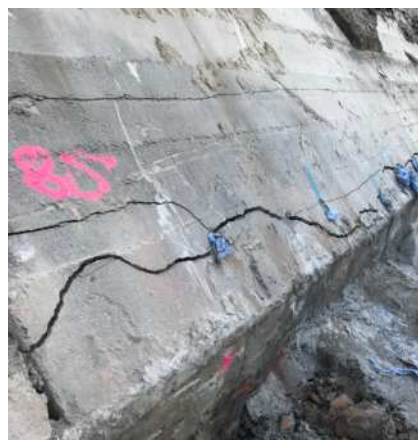
Parete in calcestruzzo fessurata in modo controllato lungo la fila di fori
