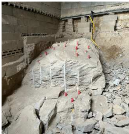
Frantumazione di roccia in cantina invece della scalpellatura
