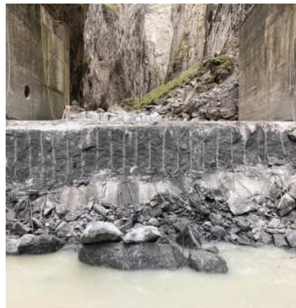
Smantellamento di una briglia in calcestruzzo in una gola
