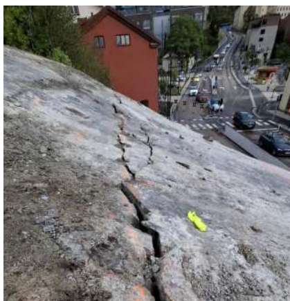
Rimozione di roccia sopra una strada trafficata
