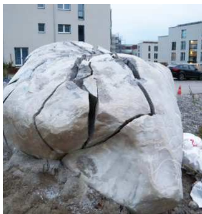
Masso erratico in zona residenziale spaccato senza vibrazioni
