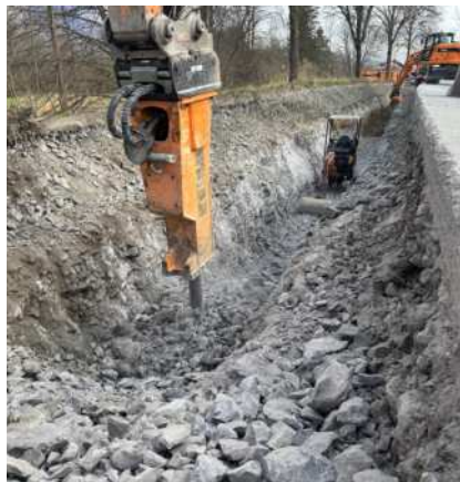
Scavo di trincea nella roccia – materiale allentato in anticipo
