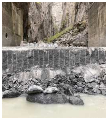
Demolição de uma barreira de betão no desfiladeiro
