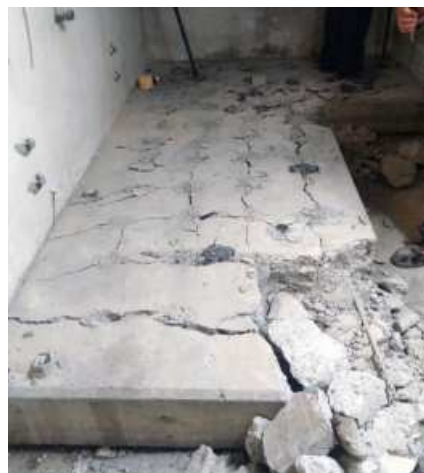
Fundação de betão demolida em espaço interior
