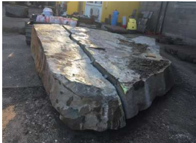
Bloco de rocha fraturado sem vibrações – sem ruído, sem detonação.
