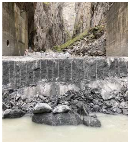
Uklanjanje betonske pregrade u klisuri
