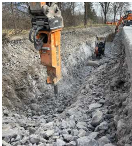
Iskop rova u steni – materijal prethodno razrahljen
