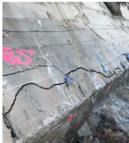
Betonski zid kontrolisano ispucao duž reda rupa
