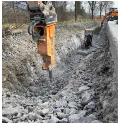
चट्टान में खाई की खुदाई – सामग्री पहले से ढीली की गई
