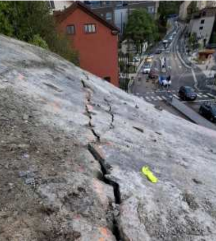
Trafiğe açık bir yolun üzerinde kaya sökümü
