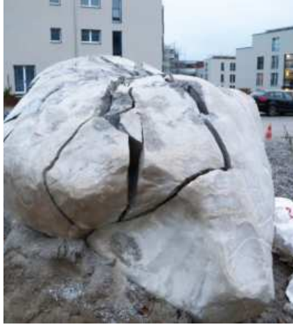
Yerleşim alanındaki ayırık kaya sarsıntısız kırıldı
