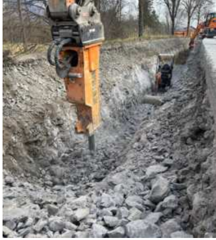
Kayada hendek kazısı – malzeme önceden gevşetildi
