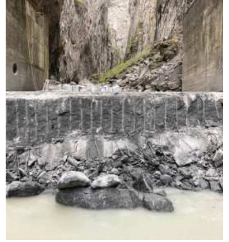
Kanyonda beton bir bariyerin sökümü
