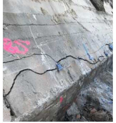
Beton duvar delik sırası boyunca kontrollü bir şekilde çatlatıldı
