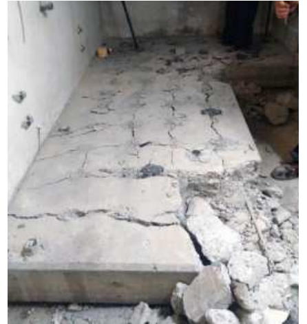
İç mekandaki beton temel yıkıldı
