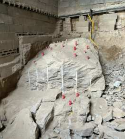
Bodrum katında kırma yerine kaya sökümü
