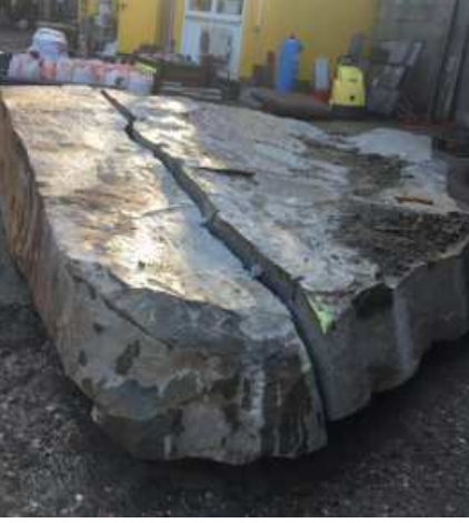
Arazideki kaya bloğu kontrollü bir şekilde kırıldı
