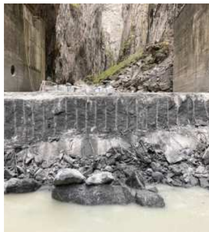
Rušenje betonske pregrade v soteski
