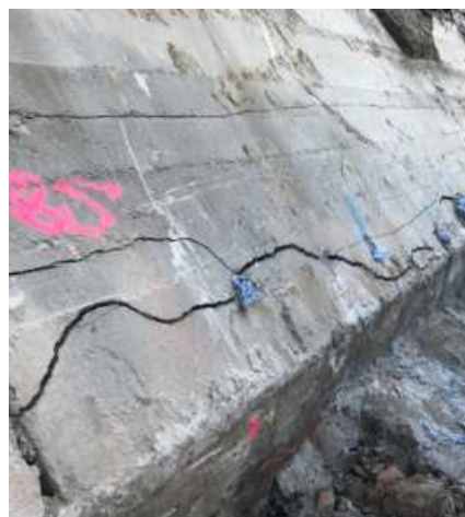
Nadzorovano pokanje betonskega zidu vzdolž vrste vrtin
