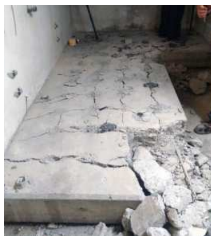
Rušenje betonskega temelja v notranjosti
