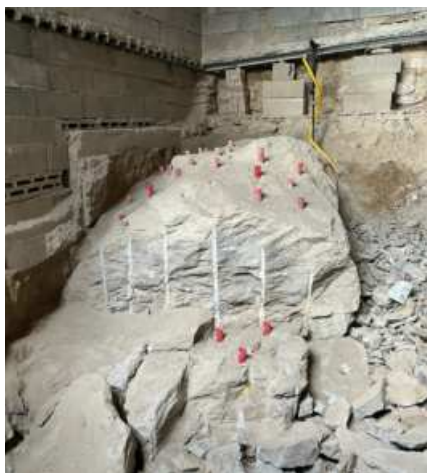
Demolice skály ve sklepě místo sekání
