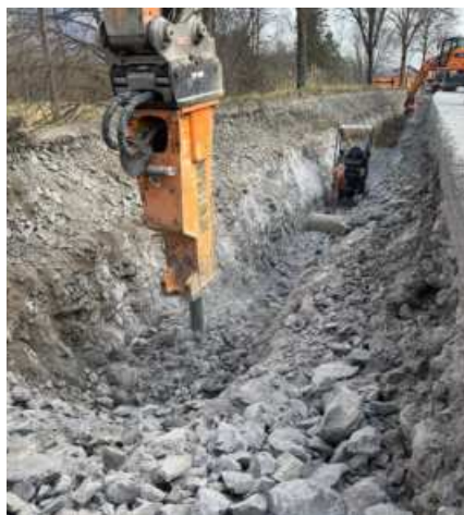
Výkop příkopu ve skále – materiál předem rozrušen
